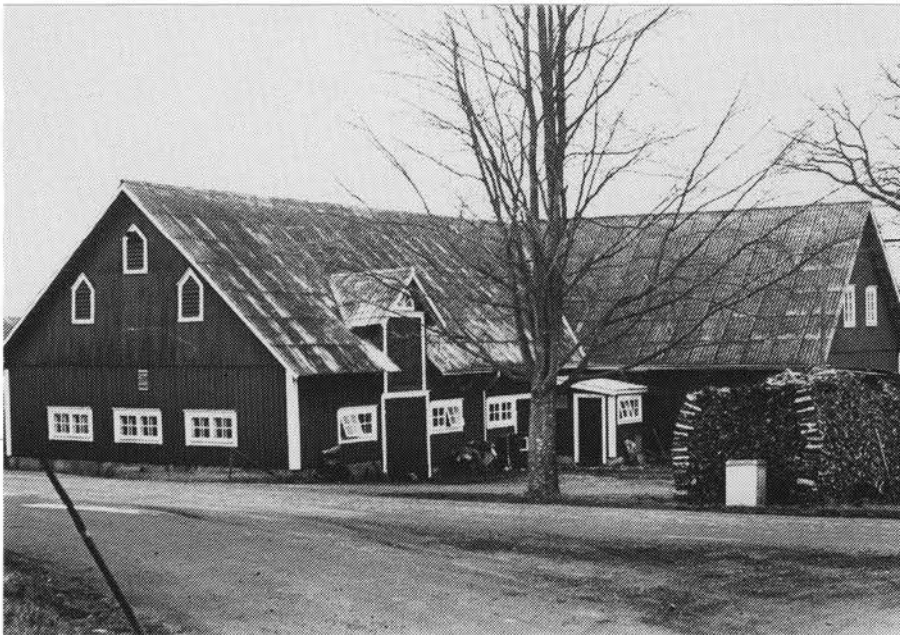
Ladugård i timmer och resvirke, Odenslanda, Vederslövs sn
